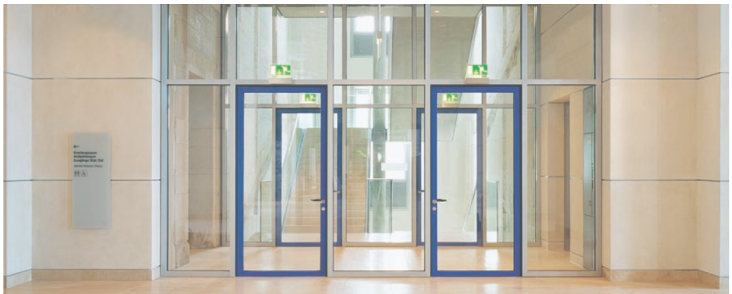
MBB SYSTEM 2000 im Reichstag, Berlin: Brandschutztüren und Verglasung T30, F30
